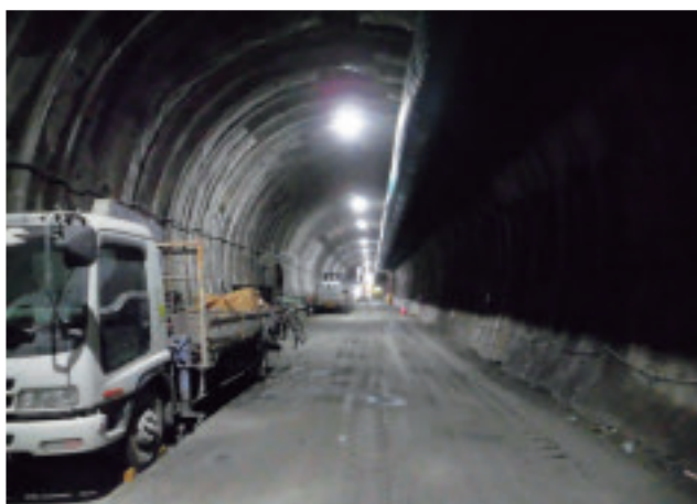
トンネル掘削中の本坑
