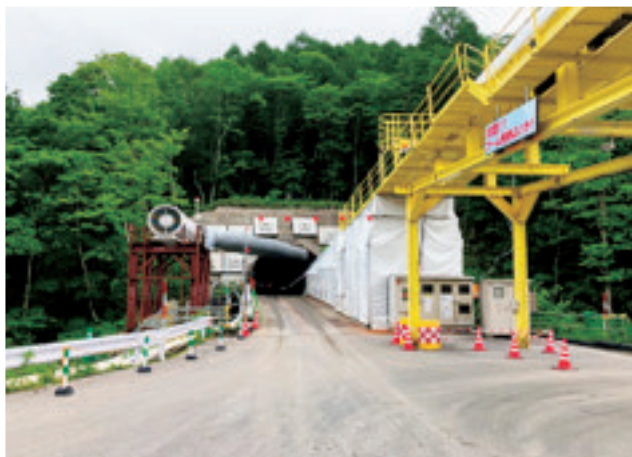
トンネル坑口
