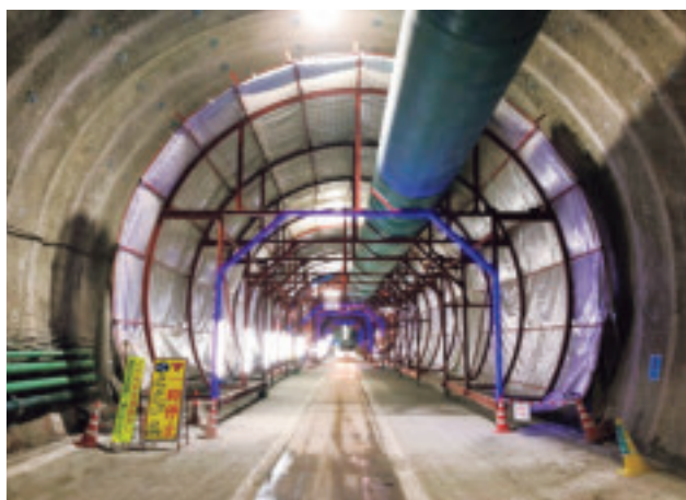
覆工コンクリートの品質を確保するミスト養生設備
