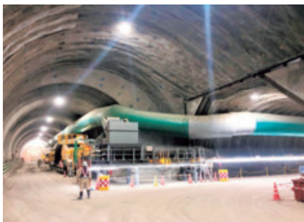
高い技術が必要な斜坑と本坑の交差点
