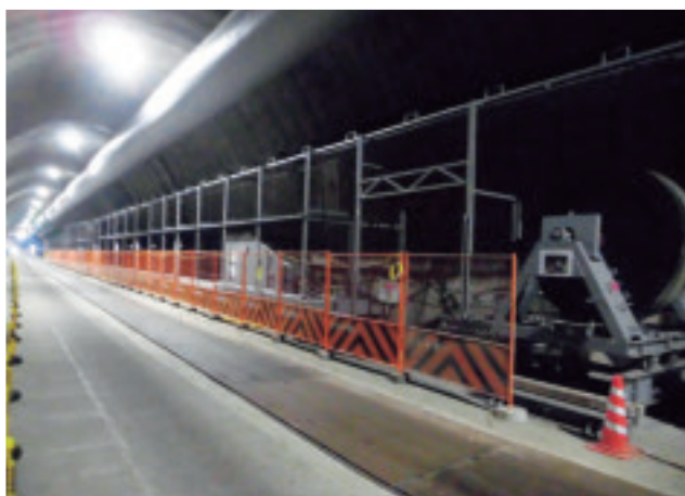
長大トンネルの掘削土搬出に有効なベルトコンベア
