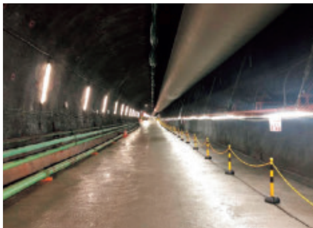
施工済みの斜坑(坑口から本坑まで)
