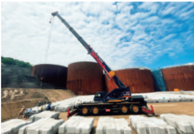
〈苫小牧市〉覚生川3号砂防堰堤の工事現場にて 根固めブロック(10t級/基)の敷設状況などを見学
