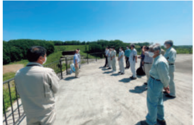
〈苫小牧市〉覚生(おぼっぶ)川2号砂防堰堤(えんてい)の 右岸側天端にて事業概要の説明を受ける
