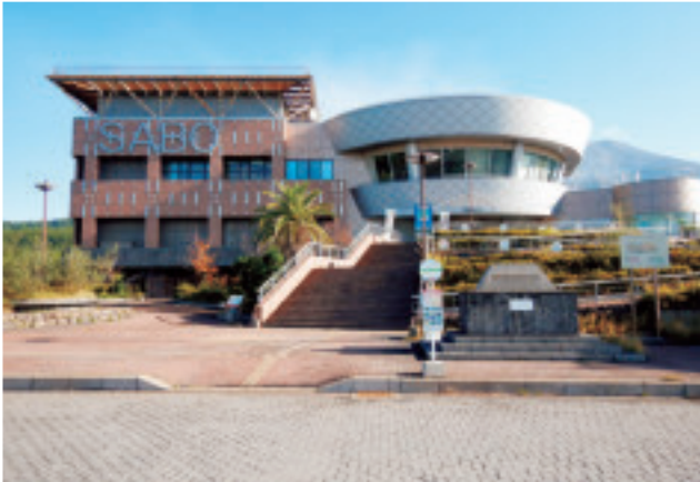
〈鹿児島市〉「桜島国際火山砂防センター」の外景 噴火時の噴石等を想定して管理施設部分(右側)は逆円錐形
