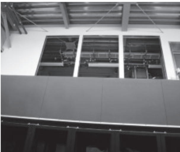
写真-3 データセンター棟天井等上部構造の様子
