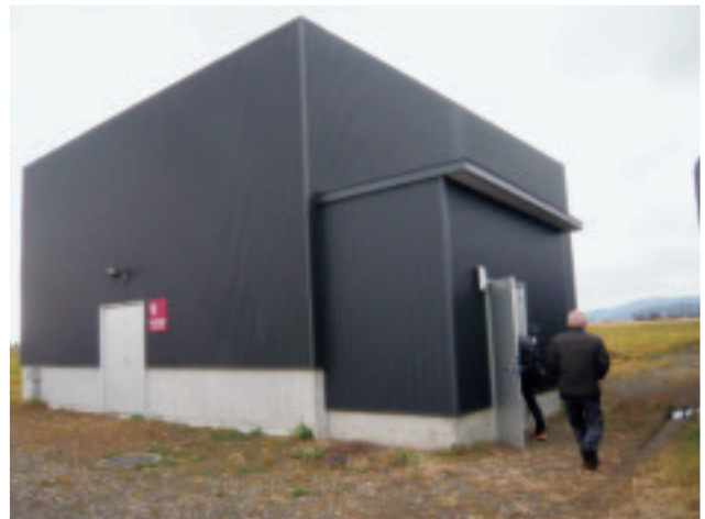
ホワイトデータセンター棟の外側の概観(平屋建てだが階高が3階分程度ある)
