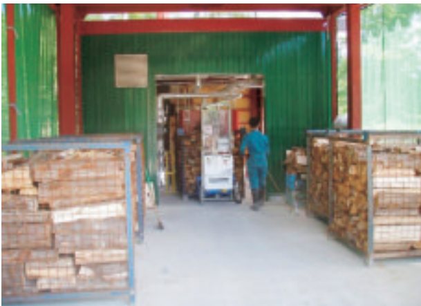
占冠村 薪ボイラ建屋前室
