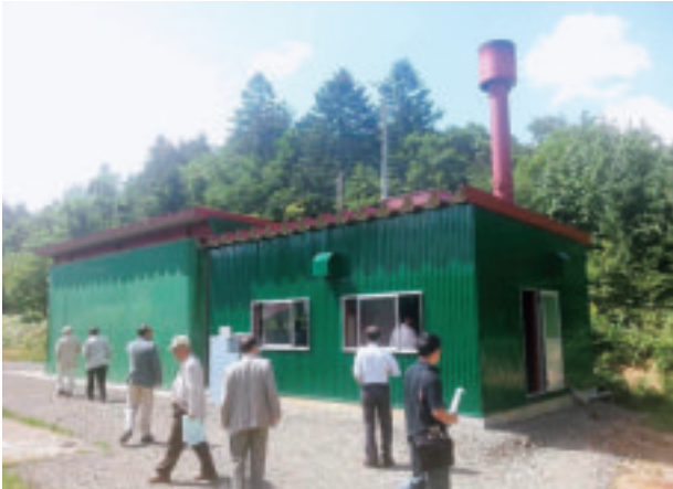
占冠村 薪ボイラ建屋全景
