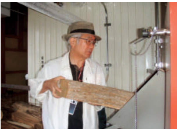
占冠村 薪ボイラへ薪の投入体験をする参加者
