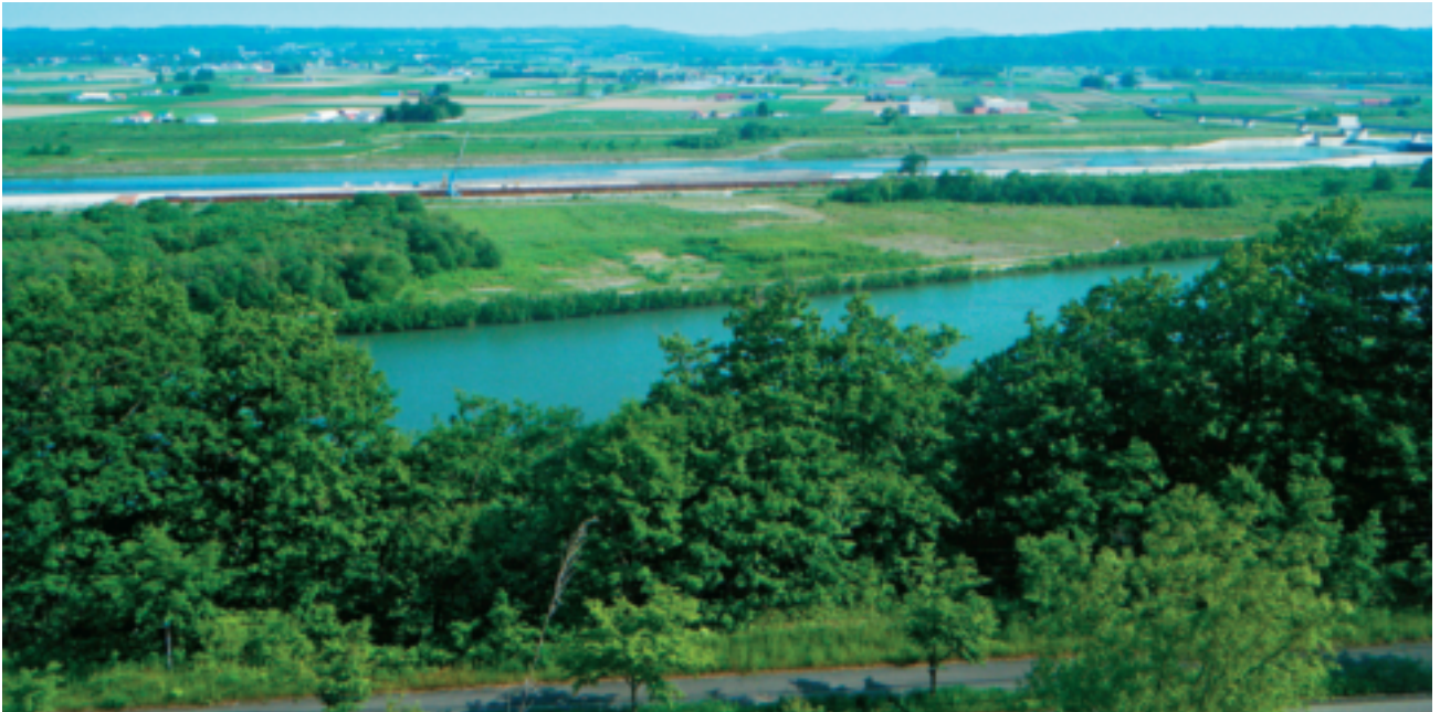
千代田新水路全景
