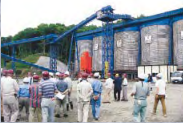
【当別ダムコンクリート製造プラント】
