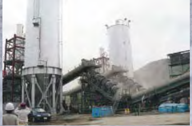
【当別ダム CSG 製造プラント】
