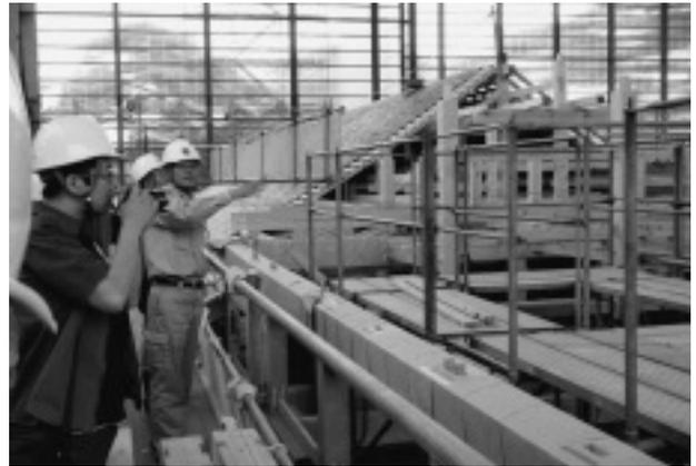
完成後はこのように見えるようにと工事が進められている。出来上がり図面を外壁に画いてその通りに作り上げていくその復元作業は、建築工事というより、まるで彫刻の作業のようである。
