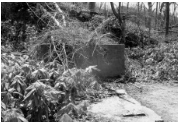
写真-4 索道アンカーレッジ
