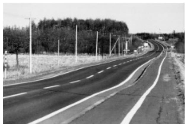
写真2 泥炭地盤上の道路の沈下
